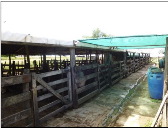
Galpón de servicio-gestación. Vista general.
